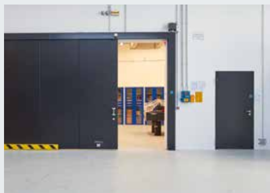
Křídlo vrat a rám s nátěrem
